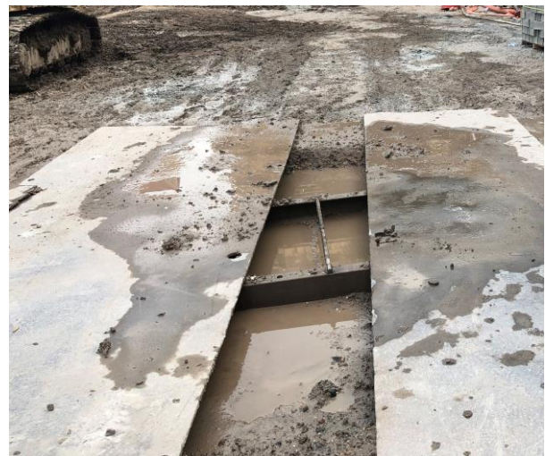
Hình 5: Cầu rửa xe ra vào công trình
