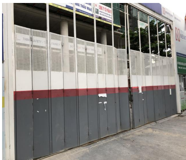
Hình 10: Tường chắn ngăn cách công trình và khu vực xung quanh
