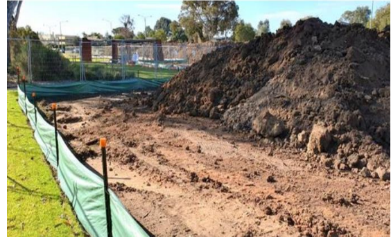
Hình 7: Tường chắn mềm khu vực lưu trữ đất đào nền, móng
