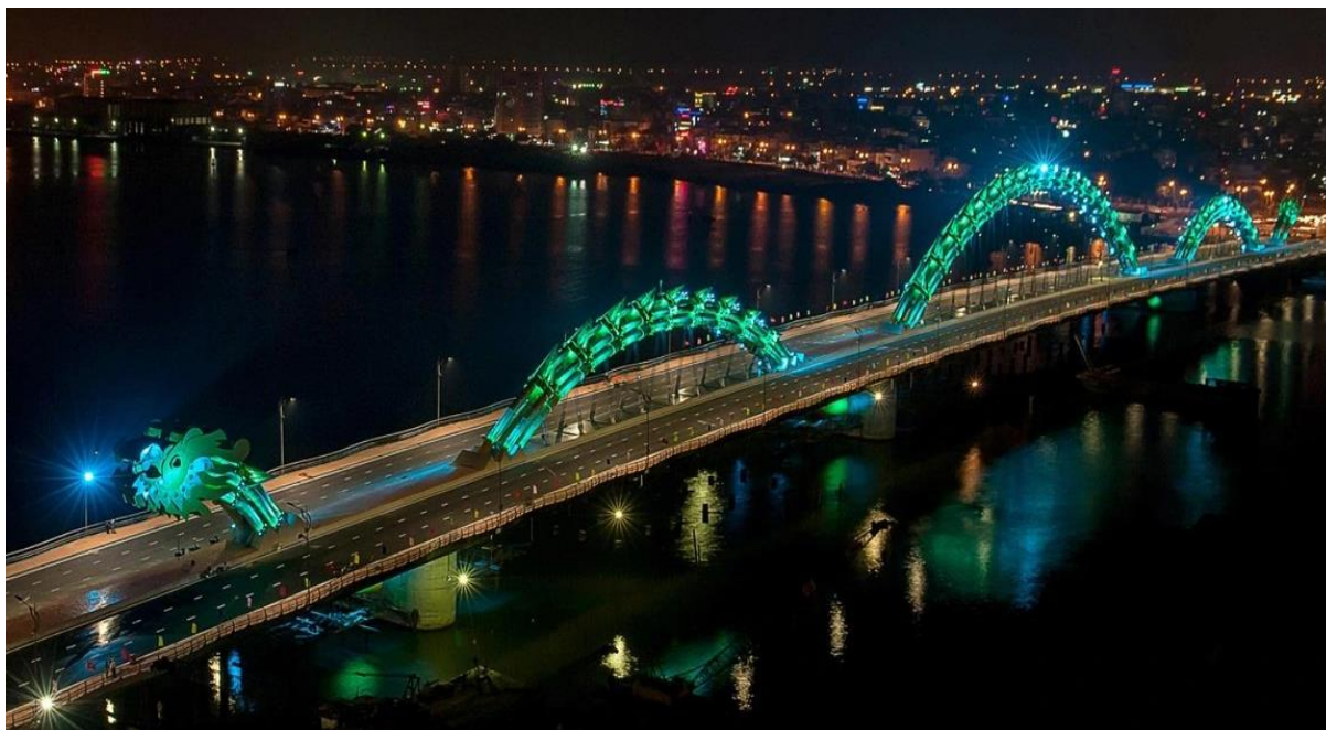
Hình 3.24. Hệ thống chiếu sáng tại Cầu Rồng, Đà Nẵng do Signify cung cấp giải pháp
