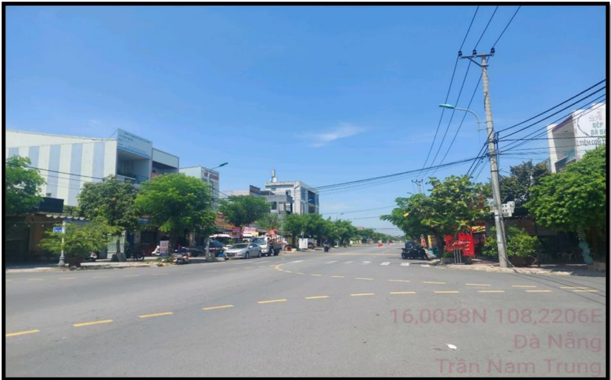
Hình 2.10. Hệ thống chiếu sáng trên đường Trần Nam Trung
