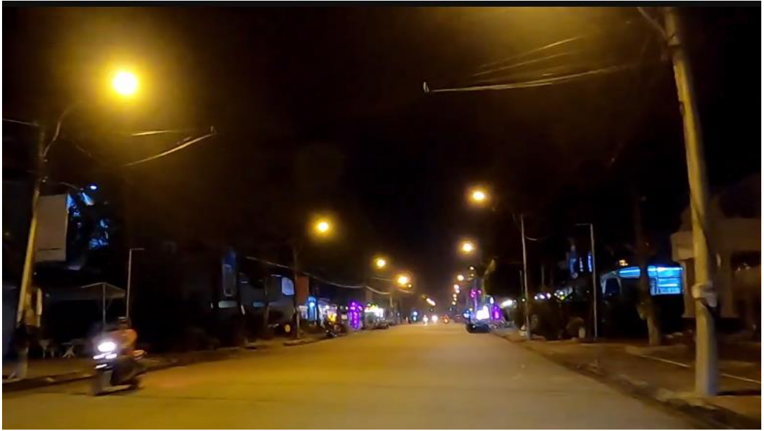
Hình 2.17. Hệ thống chiếu sáng giao thông KDC Huỳnh Châu, quận Thốt Nốt
