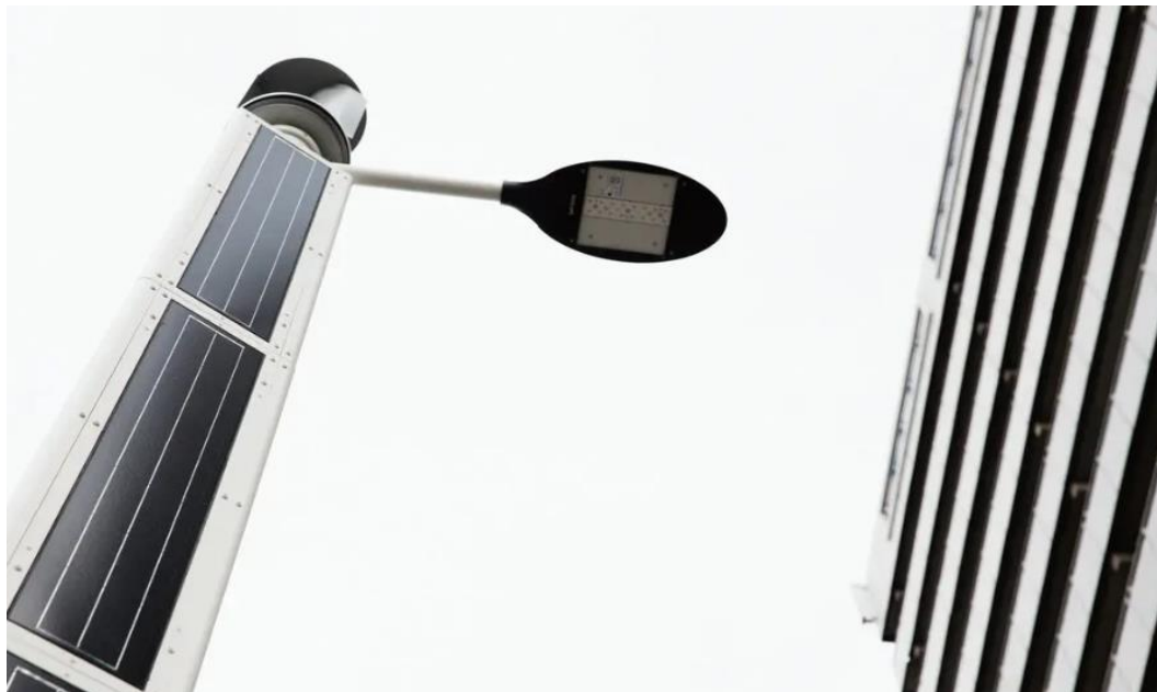
Hình 3.15. Đèn đường tích hợp điều khiển cường độ sáng, cảm biến chuyển động, giám sát vận hành bằng wifi, tự cung cấp điện bằng nguồn năng lượng mặt trời
