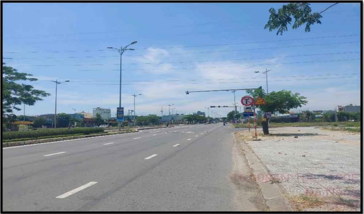
Hình 2.8. Hiện trạng hệ thống chiếu sáng trên đường Võ Chí Công
