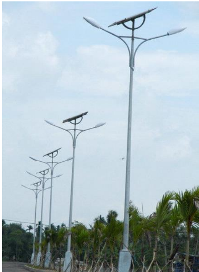
Hình 2.20. Hệ thống chiếu sáng trên đường Trần Nam Trung
