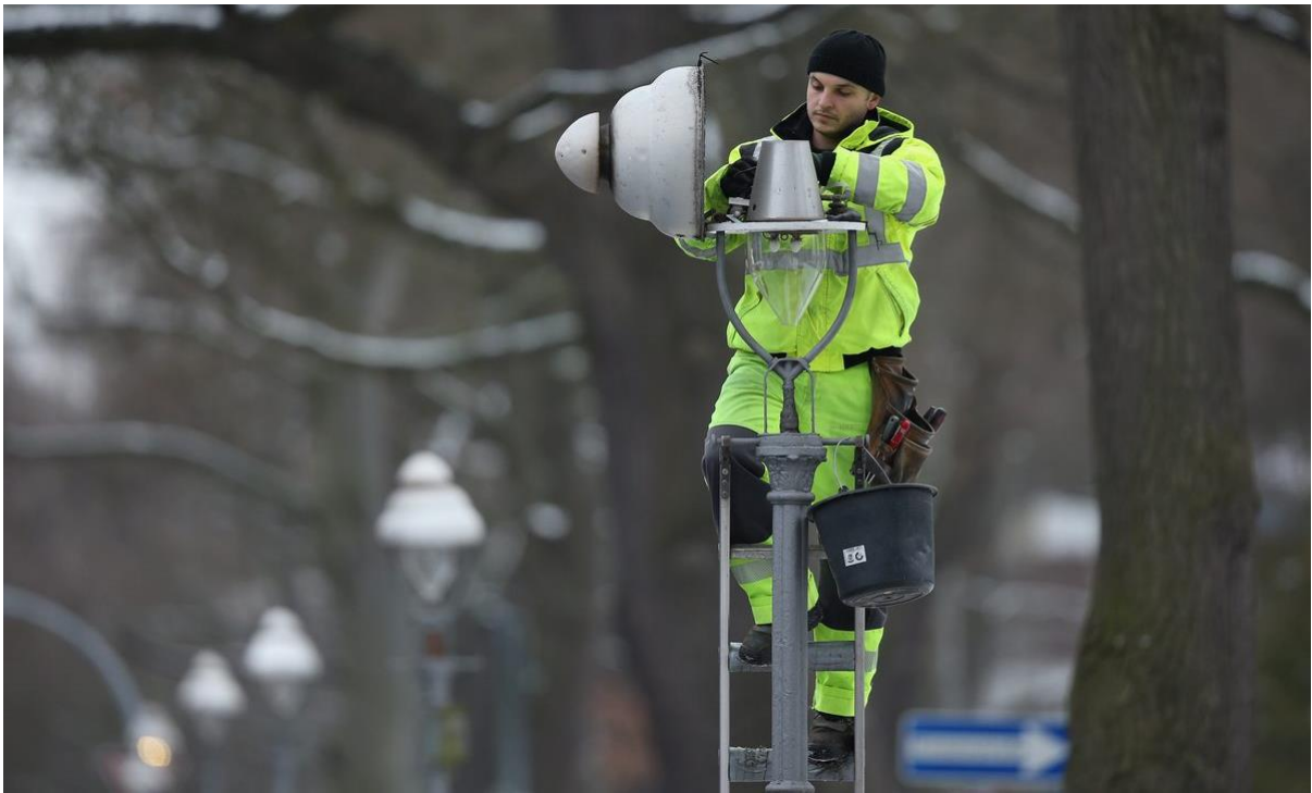
Hình 3.18. Thay thế đèn khí đốt bằng đèn LED ở đường phố Berlin, Đức
