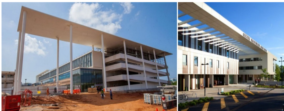
Hình 8 Ví dụ giải pháp bổ sung che nắng bằng các chi tiết kiến trúc kích thước lớn. Bên trái: Bệnh viện Ridge, Ghana (nguồn Ghanaweb.com ); Bên phải: Bệnh viện tại Arve, Đông Nam nước Pháp (nguồn www.caue74.fr )
