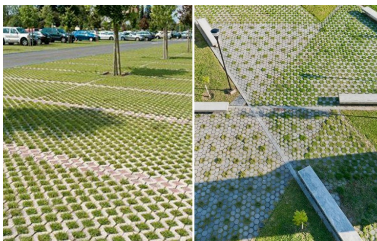
Hình 14 Sử dụng gạch lát mở với khả năng thấm nước để giảm sự tăng nhiệt của các mặt sân, bãi trong khuôn viên bệnh viện
